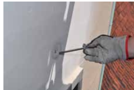
Syrafast, rostfri dubb monteras. Foto Marmor & Granit
