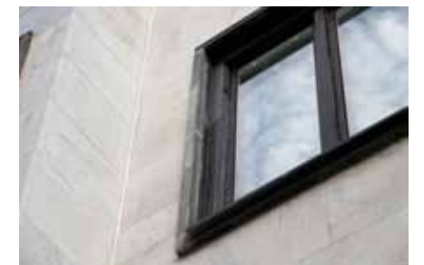
Marmorfasaden har återfått sitt ursprungliga utseende. Skillnaden i kulör och textur mellan nymonterade plattor och befintliga är minimal. Fasaden upplevs som en enhet. Foto Robert Kjellén
