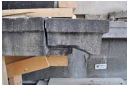
Återmontering av bottenplatta och listverk i burspråkets nederkant. Foto Marmor & Granit
