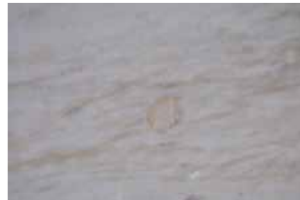
Sedan hålet lagats med stenlagning är infästningen så gott som osynlig. Foto Marmor & Granit
