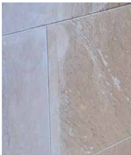
Fasadytan var patinerad med gulbrun kulör. Efter slipning återfick den i stort sett sin ursprungliga kulör. Foto Marmor & Granit
