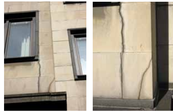
Underkant burspråk var fasadplattor av Ekebergsmarmor spräckta och listverk av Fjäråsgnejs förskjutna. Foto Christer Kjellén
