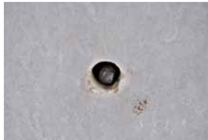
Säkringsdubb, infälld i stenytan. Foto Marmor & Granit
