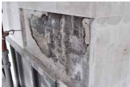
Spräckt platta har demonterats. Foto Marmor & Granit
